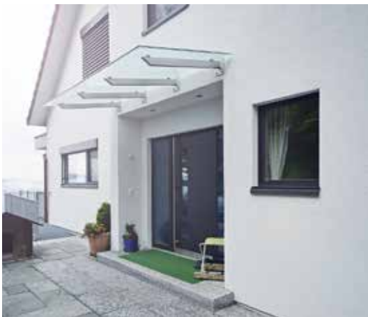
Vordachkonstruktion in Stahl und wärmegeämmte Eingangstür
