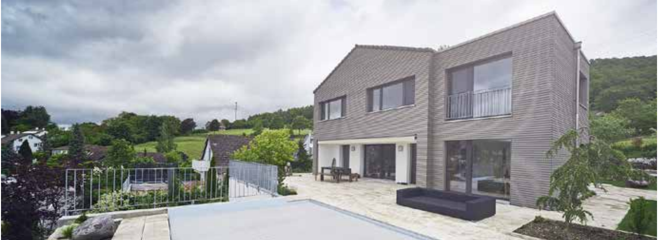
Umbau – Fassade, Elementbau und Steildach
