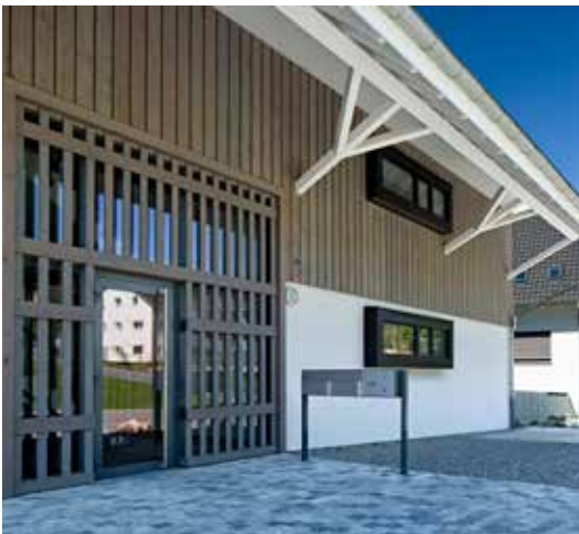
Umbau – Fassade, Dachkonstruktion, Dachfenster, Gauben und Innenausbau
