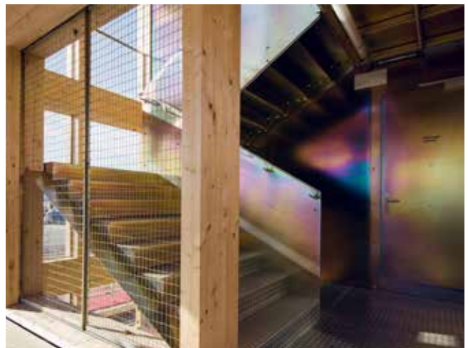
Treppenkonstruktion mit integriertem Geländer
