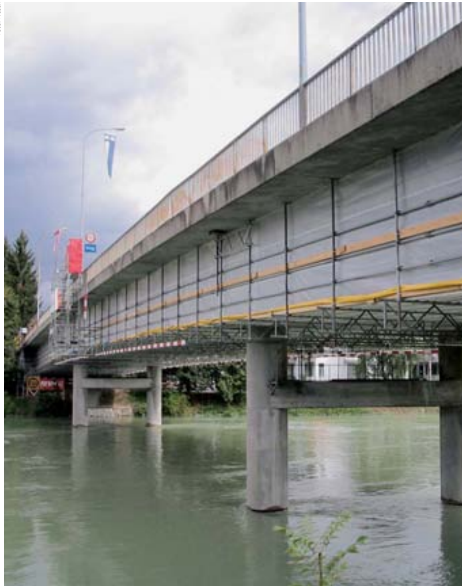
Das aufgehängte Flächengerüst ermöglicht die freie Kanaldurchfahrt. Suspended scaffolding allows unhindered canal travel.
